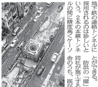
圧入ケーソン工法によって連絡トンネルを構築する
